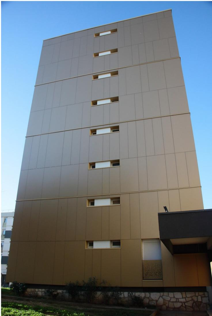
Au niveau du bâtiment X1, les locataires se plaignent du bruit que font les plaques isolantes sur le bâtiment (mauvaise fixation ?) quand il y a du vent.
